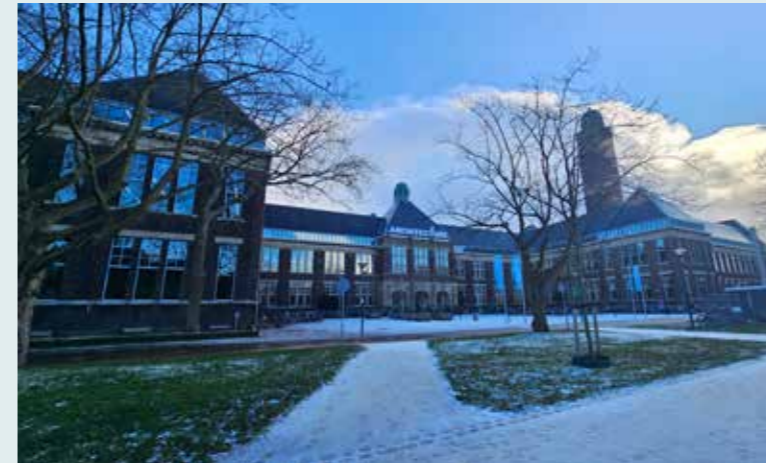
De Faculteit Bouwkunde in Delft. Foto's door auteurs
